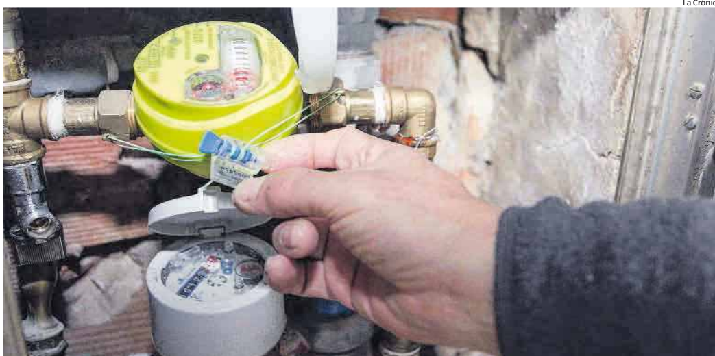
Un técnico de la empresa concesionaria comprueba un contador de agua de una vivienda.
