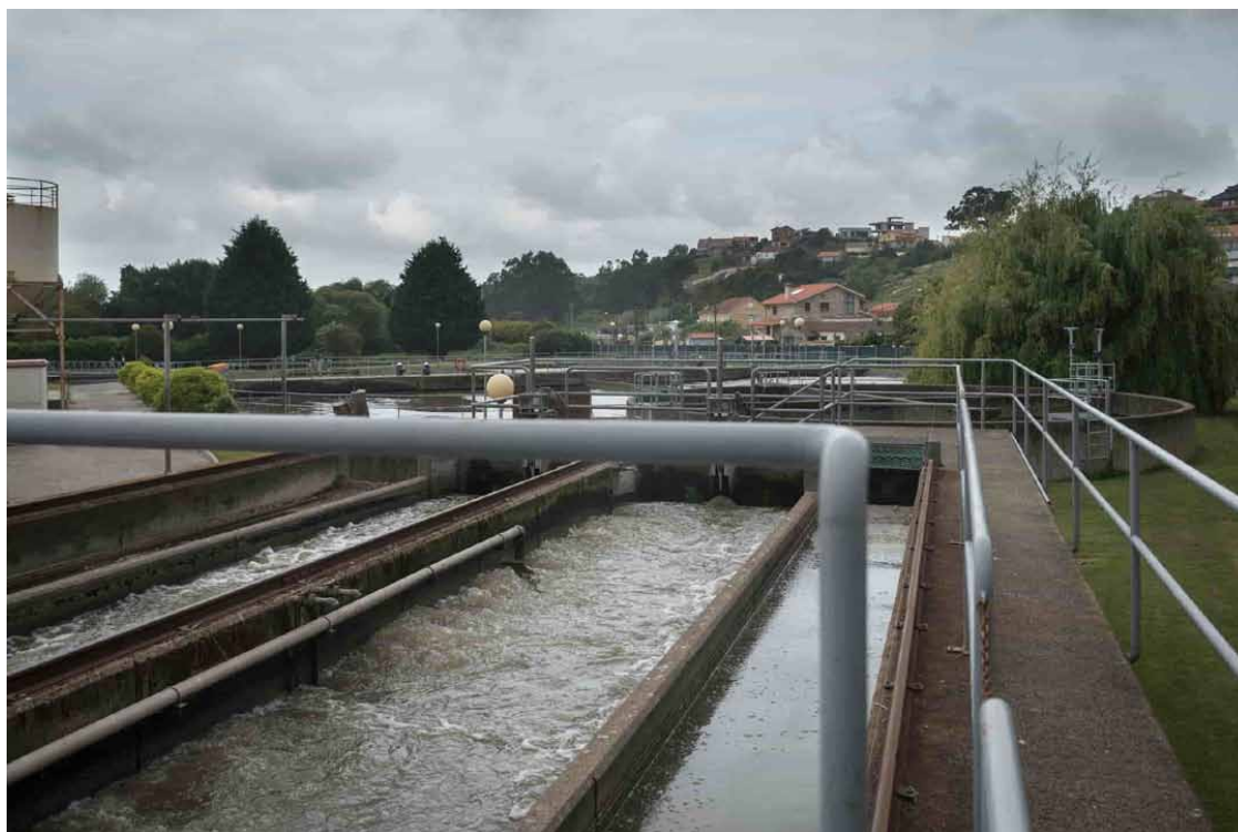
Instalaciones de Areamilla que gestiona la UTE.
